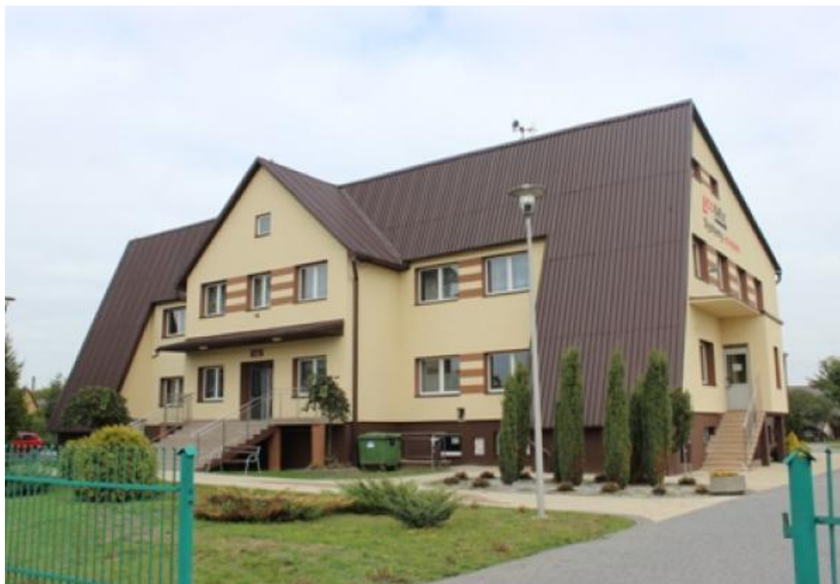
Budynek Gminnego Ośrodka Kultury w Wierzawicach
